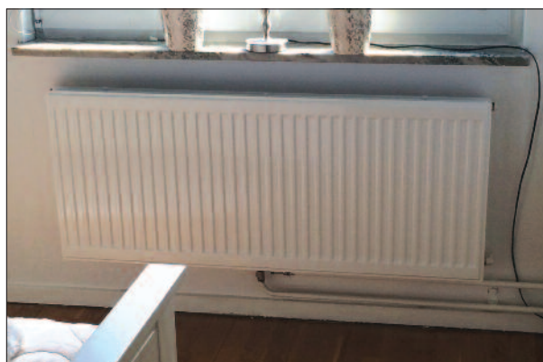
Efter bytet: PRE-radiator installerad 2015
